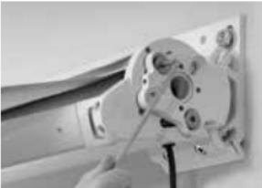
① Seitliche Innensechskantschrauben (6 mm) lösen, nicht entfernen.
