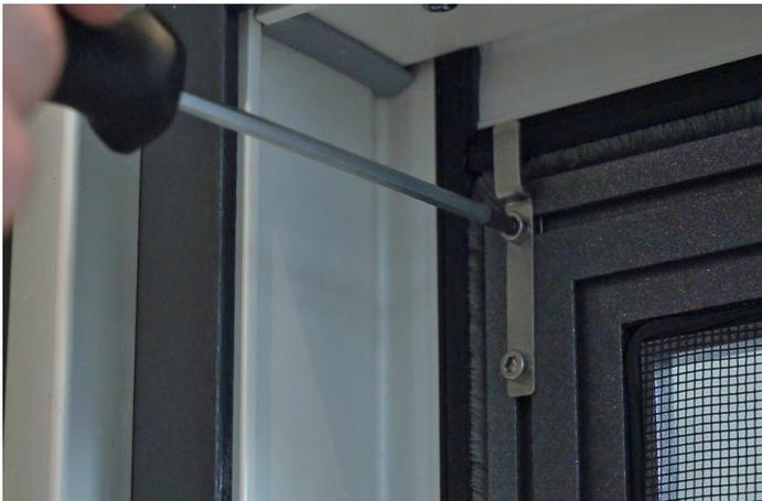
**Demontage des Insektenschutz-Spannrahmens**
