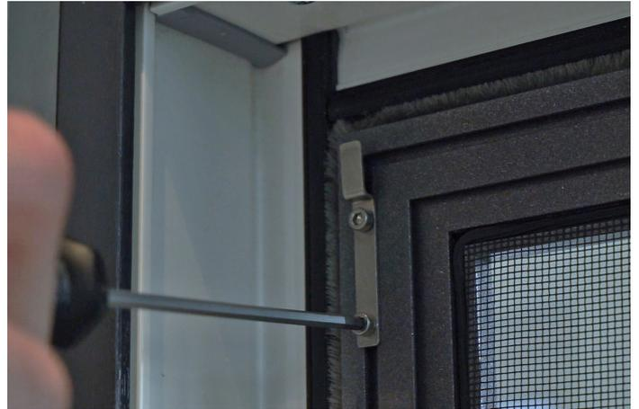
eine 1/4 Drehung lösen und die Klemmnase wieder ganz nach oben schieben. Ziehen Sie beide Schrauben der Klemmnase anschließend wieder ganz fest.
