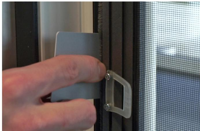
**2) Insektenschutz-Spannrahmen von außen ansetzen****Schritt 1**
