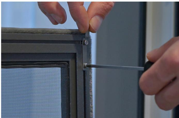
Lassen Sie den Inbusschlüssel in der unteren Schraube und schieben Sie die Klemmnase mithilfe des Inbusschlüssels zurück, bis sie nicht mehr über den Spannrahmen ragt. Ziehen Sie die untere Schraube anschließend wieder fest.
