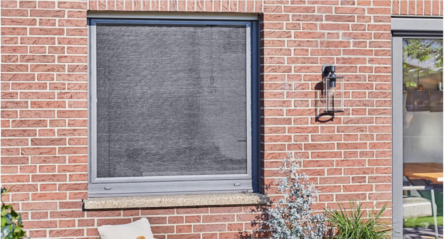
Der Insektenschutz-Spannrahmen soll in den Fensterrahmen eingesetzt werden.
