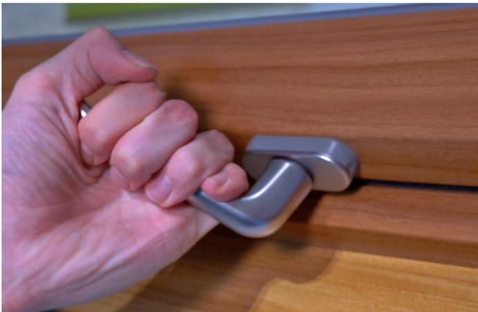
Der Schließmechanismus des Dachfensters greift nur bei ganz nach links gedrehtem Fenstergriff.
