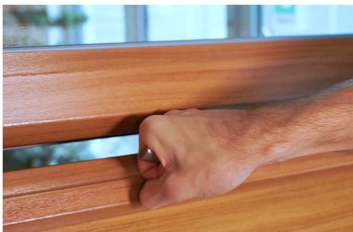
**Wichtig:** Der Schwenkriegel an der Seite muss dafür in eine der Öffnungen des Schließbocks greifen. Überprüfen Sie dies, indem Sie vorsichtig am Fenstegriff rütteln. Bewegt sich der Flügel nicht, ist das Fenster richtig in der Spaltlüftungsstellung gesichert.
