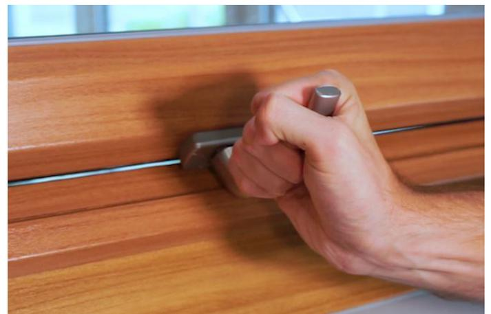
Für Spaltlüftungsstellung I drücken Sie den Flügel ca. 3 cm nach außen.
