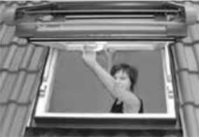
2. Schwenken Sie den Flügel langsam nach innen, bis die Oberseite (mit Ziehgriff) am Blendrahmen anliegt.
