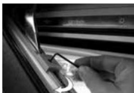
3. Ziehen Sie den Stiftschlüssel wieder ab und überprüfen Sie das stufenlose Öffnen des Renovierungsdachfensters RENOLUX. **Sollte sich nicht das gewünschte Ergebnis einstellen, wiederholen Sie den Vorgang.**
