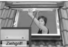
4. Ziehen Sie den Flügel am Ziehgriff an der Oberseite des Flügels nach unten.
