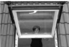
5. Schwenken Sie den Flügel soweit durch, bis die Oberseite des Flügels (mit Ziehgriff) auf Höhe der Schließböcke ist.
